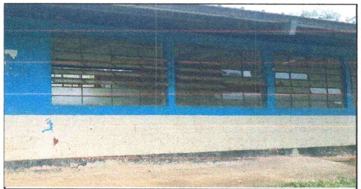
Foto 6: Sustitucion de vidrios de ventana.
