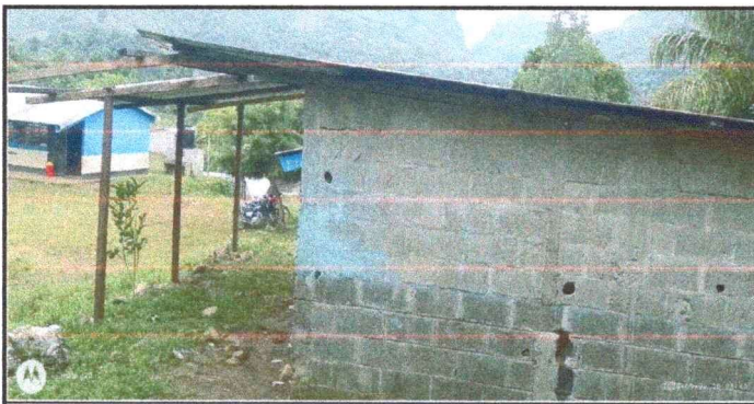
Foto 5: Repello de pared y sustitucion de lamina.
