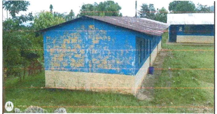
Foto 4: Mantenimiento a pared de aula
